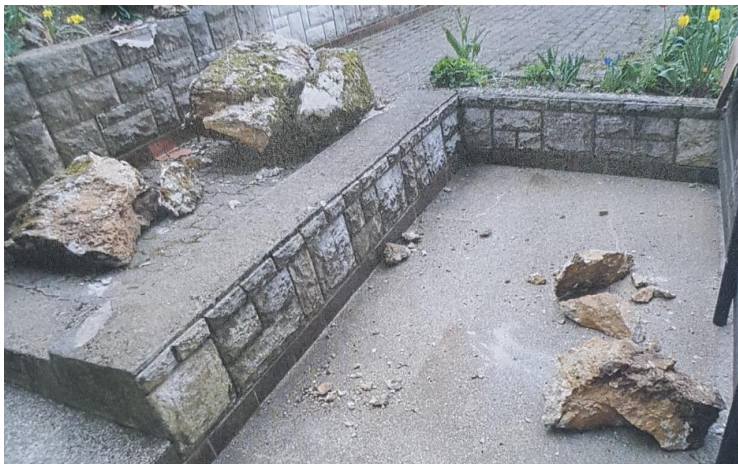
Slika 5: Skalni podor na terasah za objektom Partizanska pot 3-3a (fotografija iz projektne naloge).
